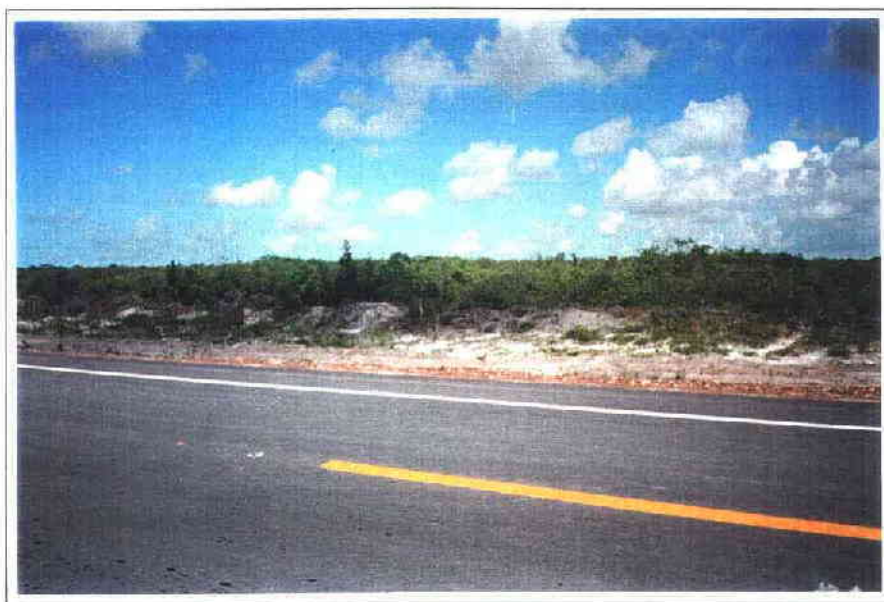
FOTO 28/32 - Observa-se, em segundo plano, uma vista parcial do trecho onde a adutora principal se desenvolve dentro da faixa de domínio da CE-422.
