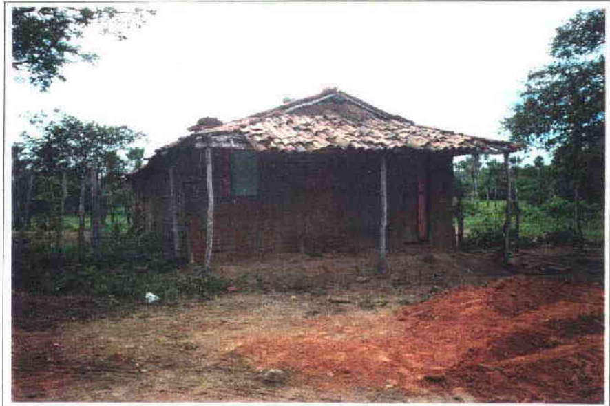
FOTO 31/32 - Casa de taipa desabitada, cuja infra-estrutura encontra-se englobada na faixa de domínio do canal adutor, próximo ao eixo da barragem Sítios Novos.
