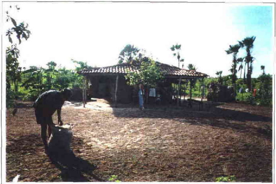
FOTO 30/32 - Habitação de taipa situada na periferia da localidade de Catuana, cuja infra-estrutura será atingida pelas obras do canal adutor.
