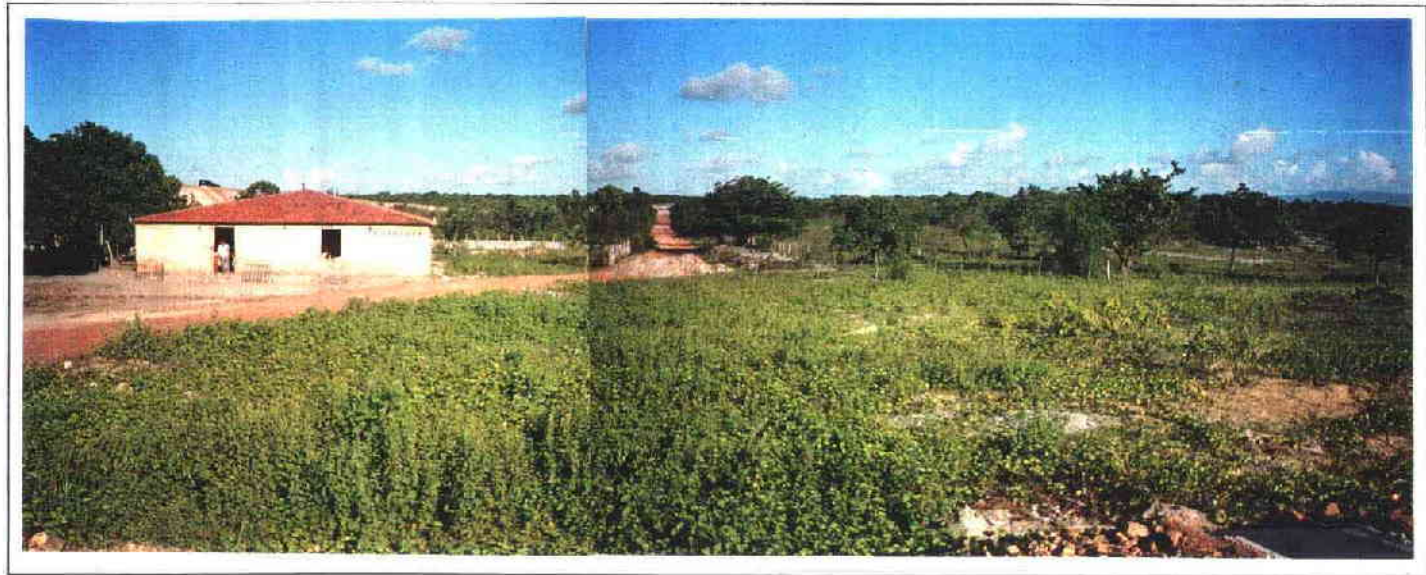
FOTO 26/32 - Trecho final do canal adutor, onde será implantado o canal reservatório e a estação elevatória principal. A habitação vista a esquerda da foto não será afetada pelas obras.
