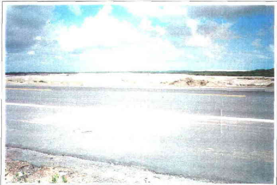
FOTO 29/32 - Ponto onde a CE-422 será interceptada pelo ramal da adutora de distribuição de água bruta. Observa-se, em segundo plano, o local onde será instalada a siderúrgica.
