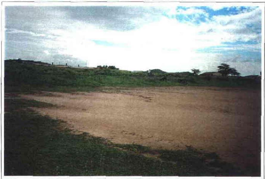
FOTO 20/32 - Ponto onde o canal adutor intercepta a CE-156 na periferia da localidade de Sítios Novos (sifão nº 02).
