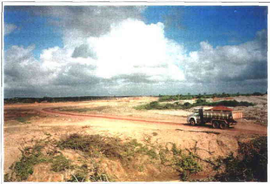
FOTO 18/32 - Açude Sítios Novos: vista parcial da área das obras.
