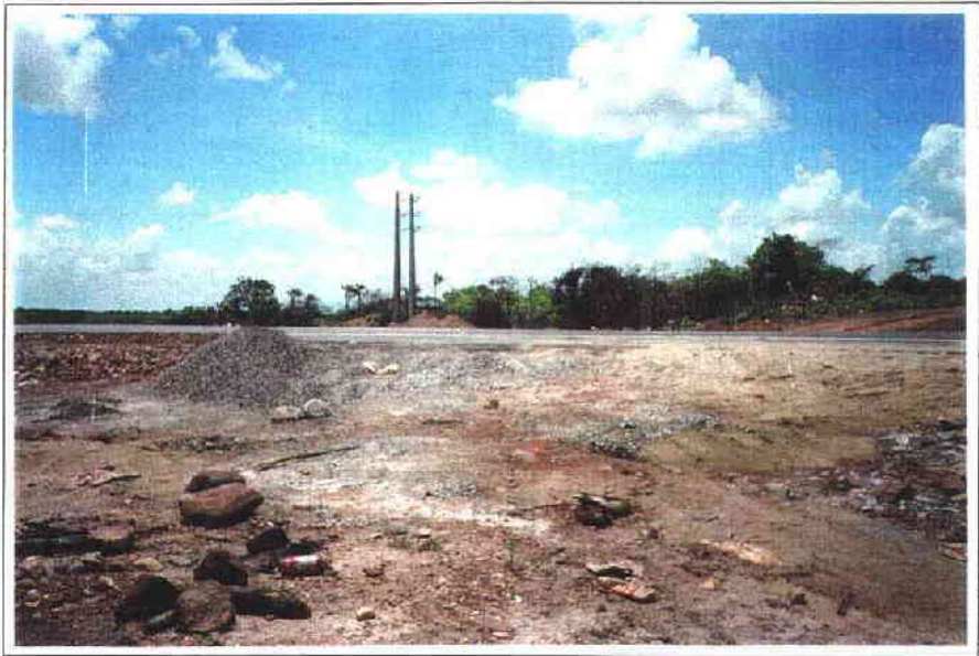
FOTO 25/32 -Ponto de travessia do canal pela CE-422, onde será instalado o sifão nº 05.
