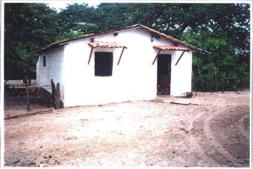
FOTO 32/32 - Habitação de alvenaria de tijolo, cuja infra-estrutura será atingida pelas obras do canal adutor. Observa-se, em segundo plano, exemplares de cajueiros, cultura bastante difundida na região onde o sistema adutor desenvolve-se próximo ao litoral.
